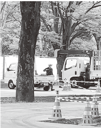
社名の無いトラックだらけの現場
